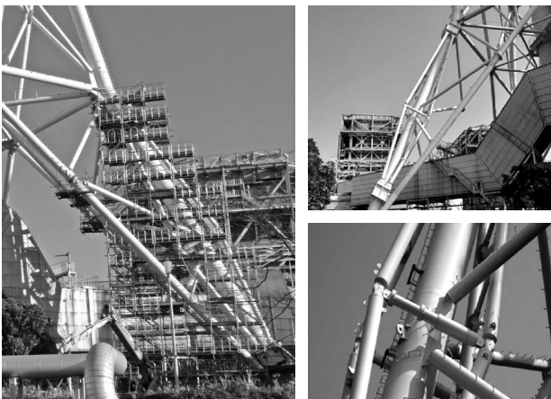
写真2 パンタグラフ型制震装置
