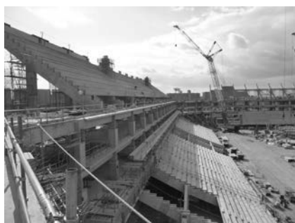
写真1 バックスタンドの施工状況
