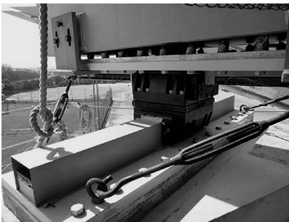
写真3 直動転がり支承の設置状況
