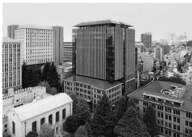
写真1 新3号館全景（中央）
