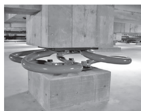
写真1 免震用 鋼棒ループダンパー
