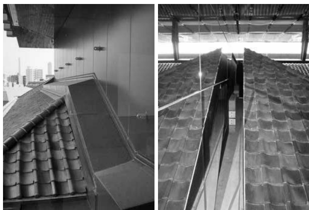
写真2 5階屋根面Exp.J (左：外部、右：内部)
