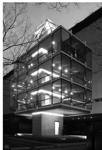
写真3 塔頂免震構造 (清水建設安全安震館,2006)
