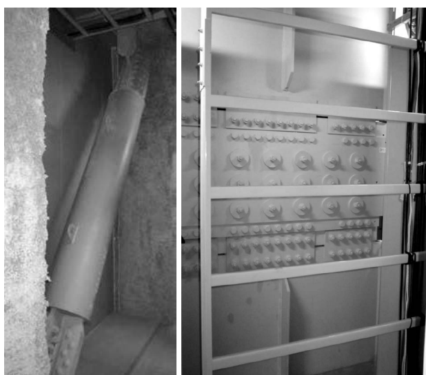
写真3 制震ダンパー (左：座屈拘束ブレース 右：摩擦壁ダンパー)
