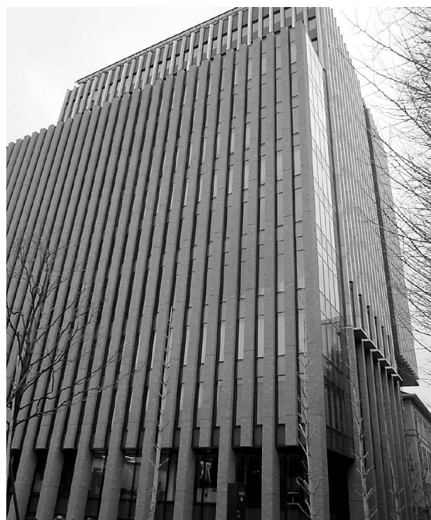
写真5 「高層棟」外観 (下階通し柱が本体SRC)
