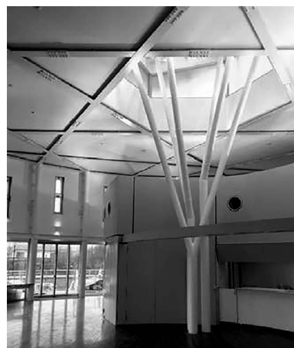
写真2 鉄骨部屋根及びY型柱
