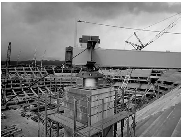
写真2 積層ゴムの設置状況
