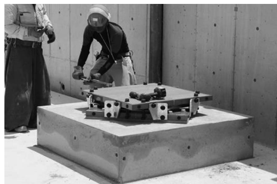
図14 球面すべり支承設置状況
