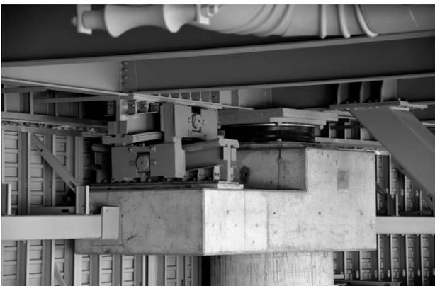
写真1.3 FPS支承と引抜き抵抗用直動すべり支承
