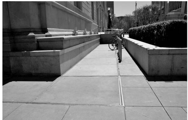
写真9.2 非免震部分との接続部 (左側が免震建物)
