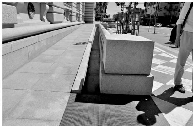
写真10.2 非免震部分との接続部（左側が免震建物）
