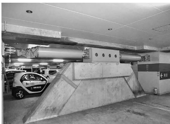
写真5 オイルダンパーの設置状況
