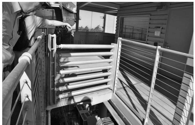
写真1.4 非免震建物との接続部（左側が免震建物）
