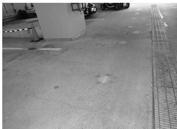
写真6 高圧噴射攪拌工法の床開口の跡
