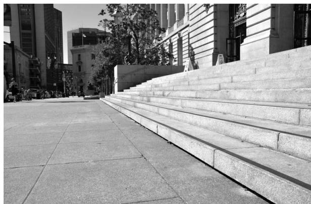
写真8.2 非免震部分との接続部（右側が免震建物）
