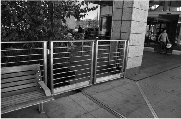
写真2.5 非免震部分との接続部 (右側が免震建物)
