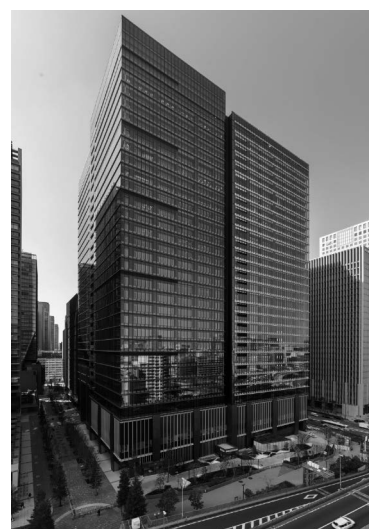
写真2.1 オフィス棟 建物全景
