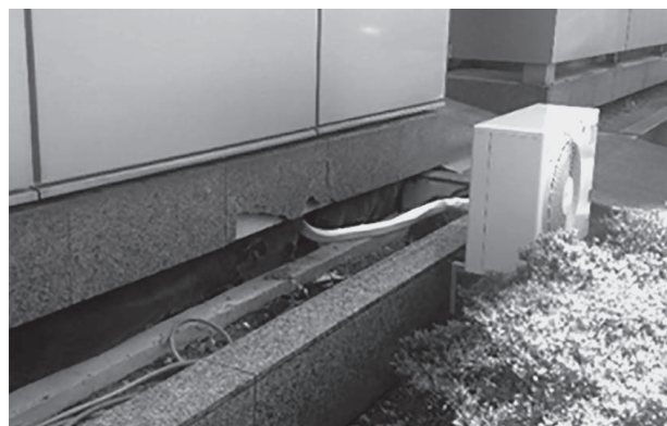
写真4 復旧された室外機
