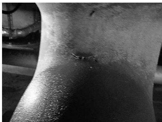
写真8 鉛ダンパーLDの亀裂状況
