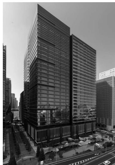
写真2.1 オフィス棟 建物全景
