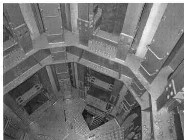
写真2 塔体内部の状況
