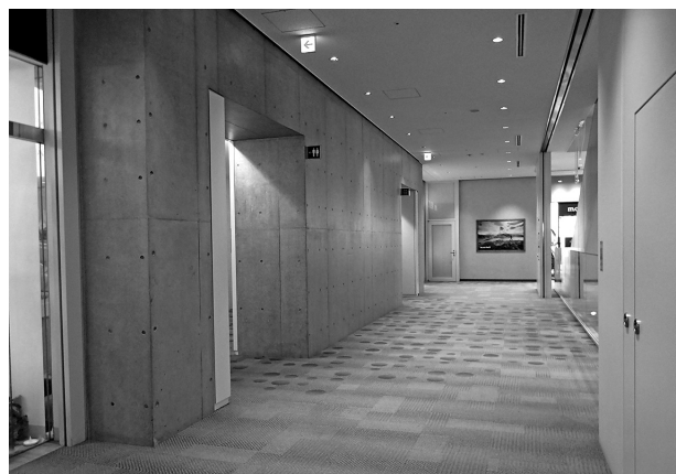
写真5 共用部のコアの耐震壁
