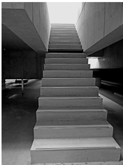
写真8 免震層への階段
