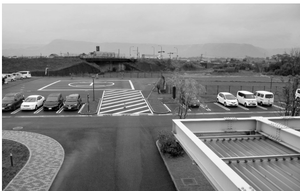
写真9 ヘリポートから建物（手前）へのアプローチ
