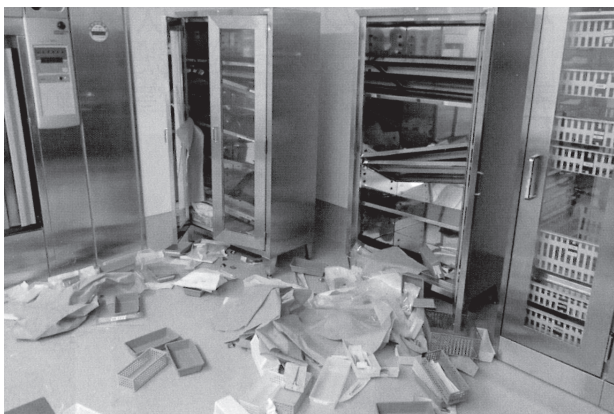
写真6 熊本地震本震直後 免震棟2階の状況
