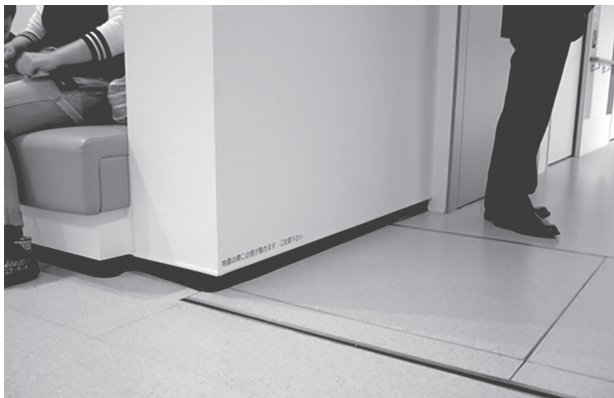
写真5 免震棟と耐震棟間のExp.Jと袖壁 (地震の際この壁が動きますとの注意書き有り)
