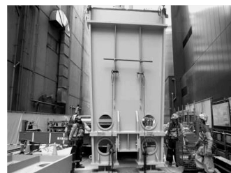
通し壁柱の建方状況 （撮影：大成建設）
