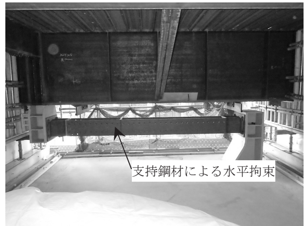
写真2 免震層水平拘束状況
