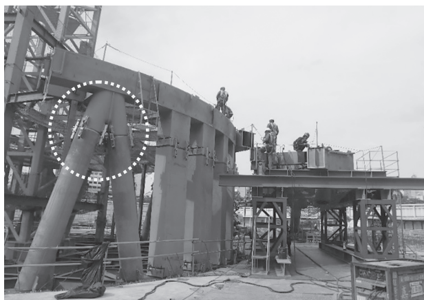
写真3 ワイヤレス建方工法エースアップ
