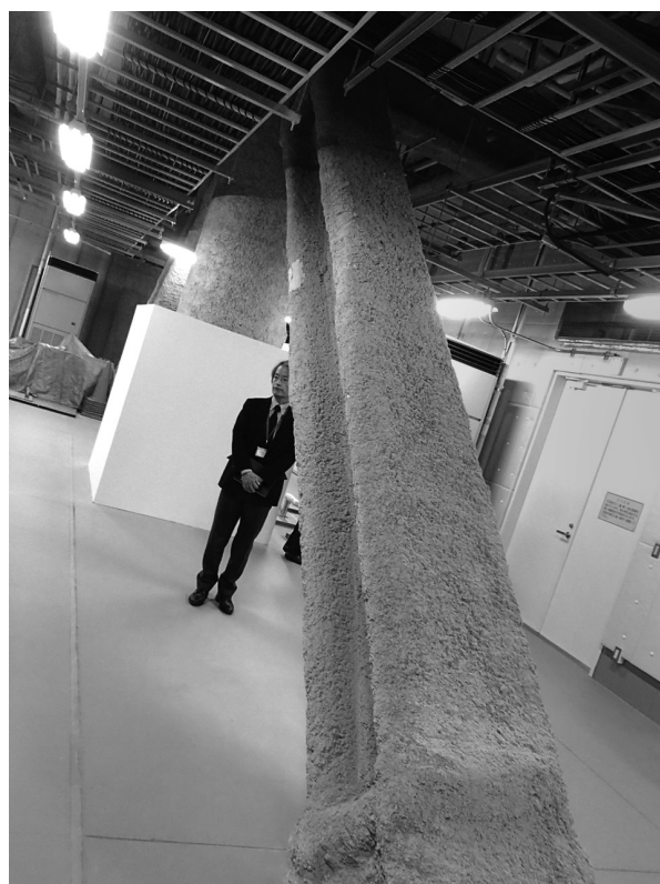
写真3 メガトラス形式の架構（免震層上階）
