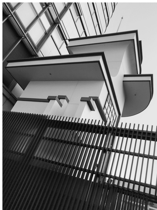
写真6 下部構造の屋上部2
