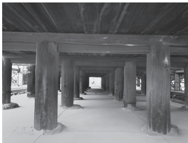
写真2 正倉院を支える40本の丸柱
