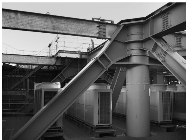
写真2 メガトラス形式の架構（屋上）
