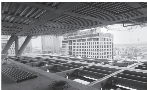
写真1 奇数階の施工状況(柱が無い空間)
