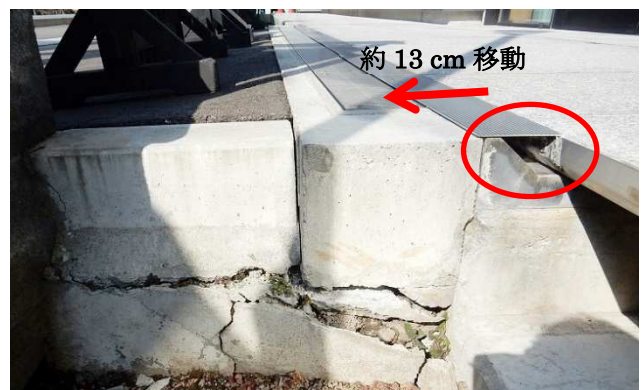
写真 5 10cm 以上移動した免震の犬走り部分が、周辺の外構部に衝突し、破壊した例
