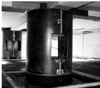
基礎免震の東館は、中庭側から東館側面を掘り下げて、既存のフーチングの下側を掘削、既存RC杭を露出させる。既存フーチングとの間に免震支承分のすき間を空けて既存杭を抱き込む形で新設フーチングを設置。免震支承を挿入した後、杭を切除し、荷重を移し替える。ここでも既存の杭を生かしながらの施工で、最低限のサポート以外の仮設材はほとんど不要にした。
