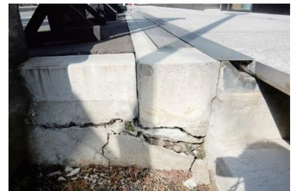
写真2 跳ね上げ式のExp.Jが接する外構の損傷例
