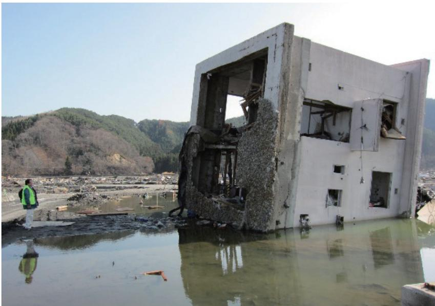
写真1 津波で転倒したRC造建物
