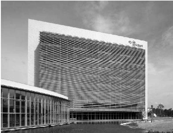
建物外観1 (撮影：竹中工務店)
