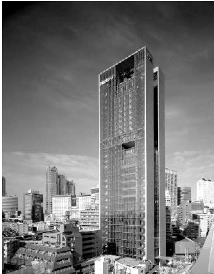
建物全景 南東 (撮影：ナカサアンド パートナース)
