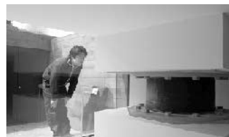
免震ピット見学スペース
