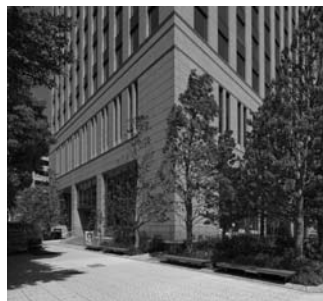
建物基壇部（外観） （撮影：SS大阪 清水向山）
