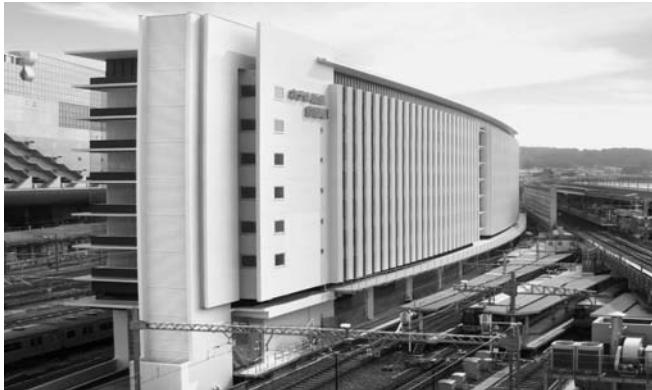
建物外観（西面）
