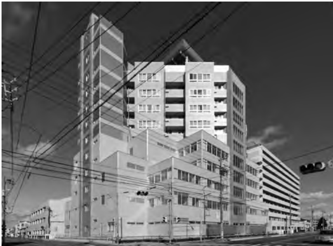
建物外観（撮影：SS 名古屋）
