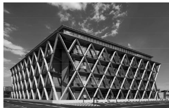
建物外観 (撮影：堀内広治)
