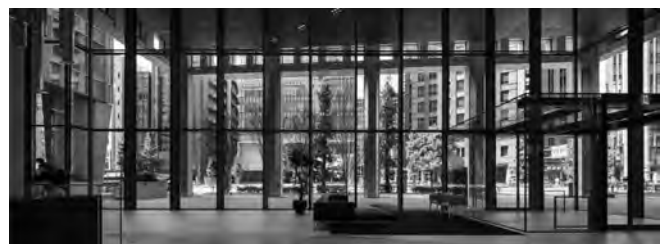
ピロティ空間
