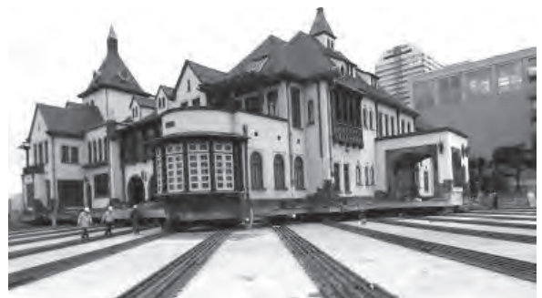
旧李王家曳家の状況
