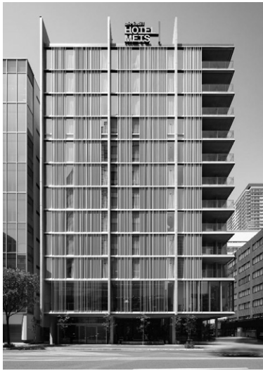
建物外観 (提供: 大成建設(株))
