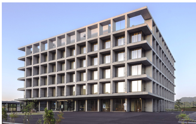
建物外観（撮影：八代写真事務所）
