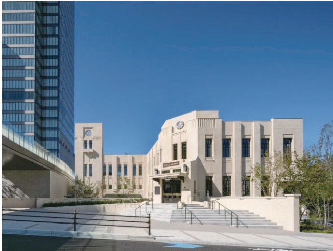
建物外観（撮影：株式会社プライズ）
