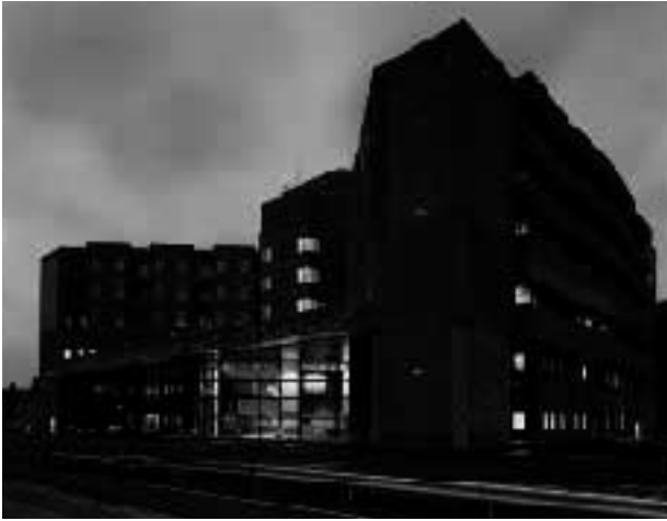
北西面からエントランスを見る
