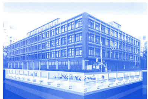
東京都豊島区役所本庁舎
