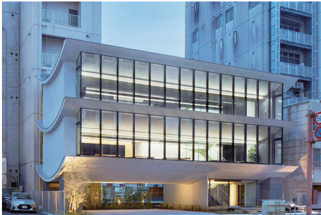
建物外観 1 (撮影: エスエス)
