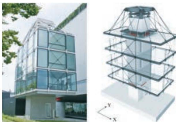
写真4 塔頂免震構造を適用した「安全安震館」
