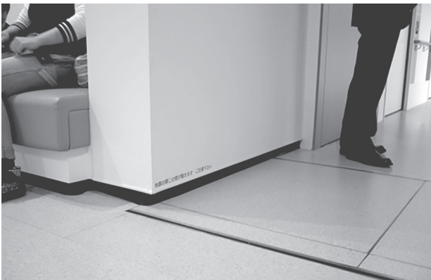
写真5 免震棟と耐震棟間のExp.Jと袖壁 (地震の際この壁が動きませんとの注意書き有り)
