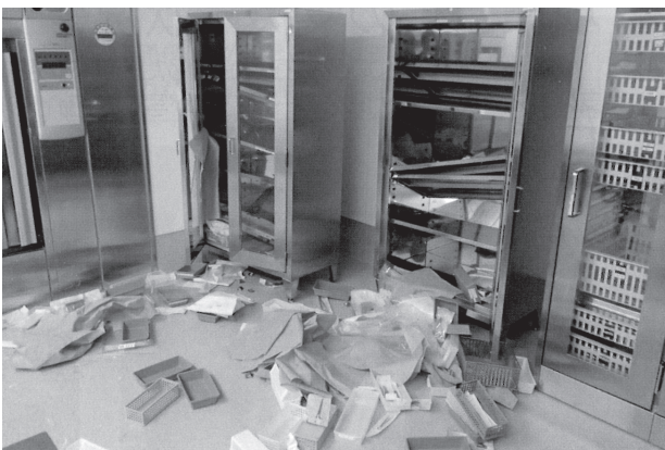
写真6 熊本地震本震直後 免震棟2階の状況
