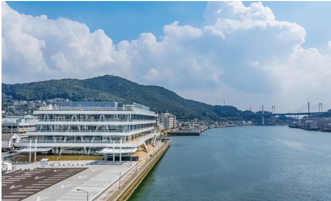
建物外観1 (撮影: SATO PHOTO 佐藤和成)
