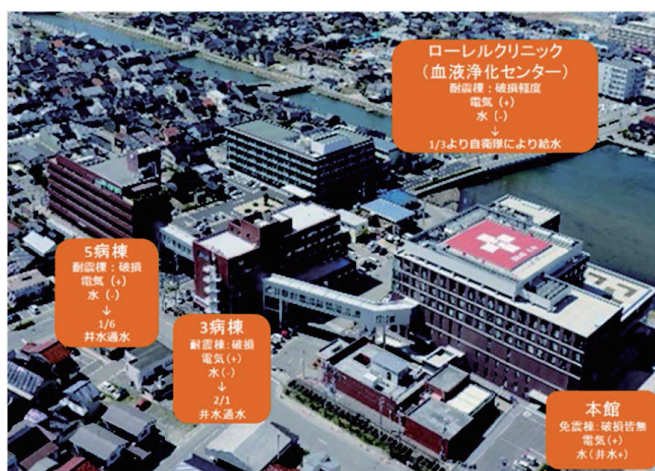
図：震災後の被災状況と対応
