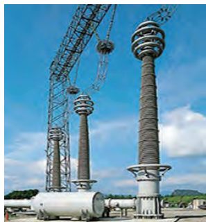
写真2 変圧器の碍子イメージ
