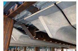
鉄骨大梁と PC-鋼合成スラブ端部
