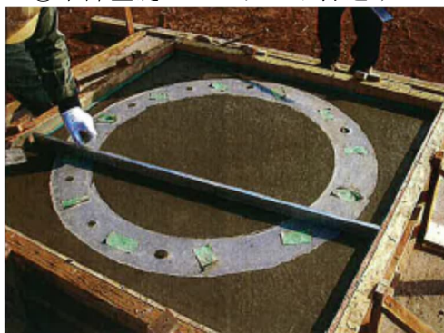
⑥コンクリート天端均し
