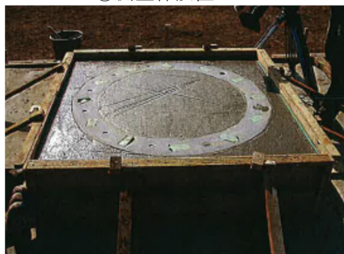
⑤コンクリート打込み完了
