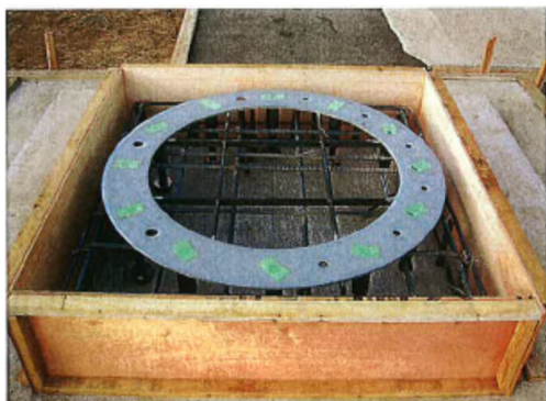
③側型枠設置
