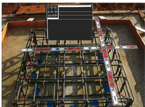
①下部基礎配筋
