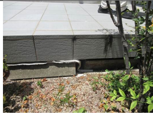
図 4.14-5 犬走りのゴムのずれ
