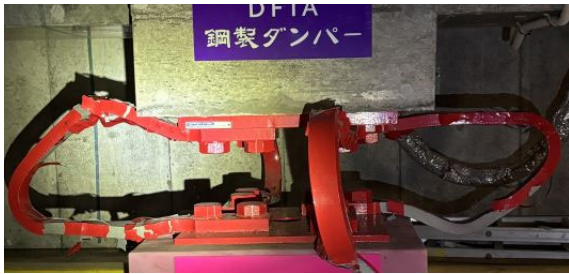
図 4.3-5 鋼材ダンパー
