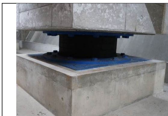
図 4.15-3 積層ゴムの様子
