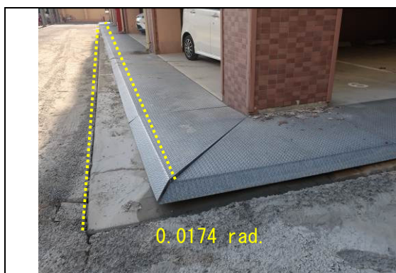
図 4.2-3 Exp.J パネルのずれ
