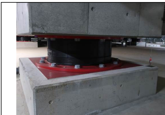
図 4.9-6 積層ゴムの様子
