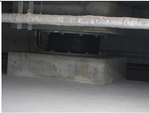
図 4.11-5 積層ゴムの様子
