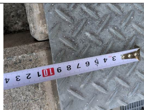
図 4.11-4 Exp.J パネルのずれ
