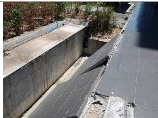
図 4.1-20 Exp.J パネルの落下
