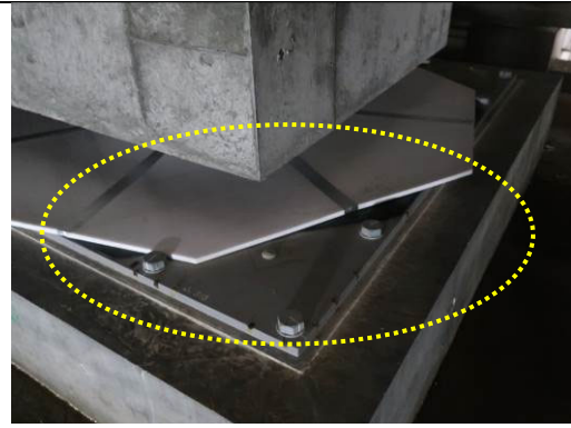
図 4.5-5 ESL 摺動部カバーのずれ
