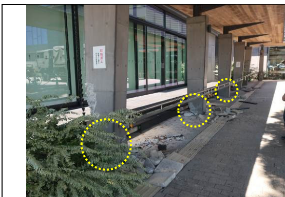
図 4.1-15 キャノピー柱との接触
