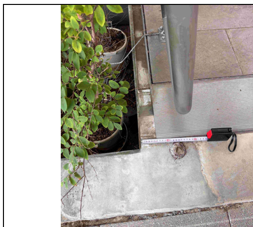
図 4.4-3 Exp.J パネルのずれ
