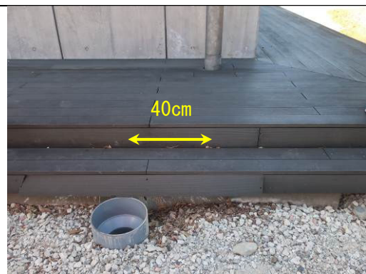
図 4.1-8 雨樋のずれ
