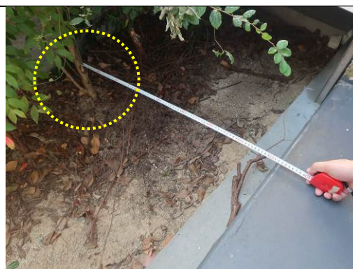
図 4.1-4 犬走りと植栽との接触（北方向）
