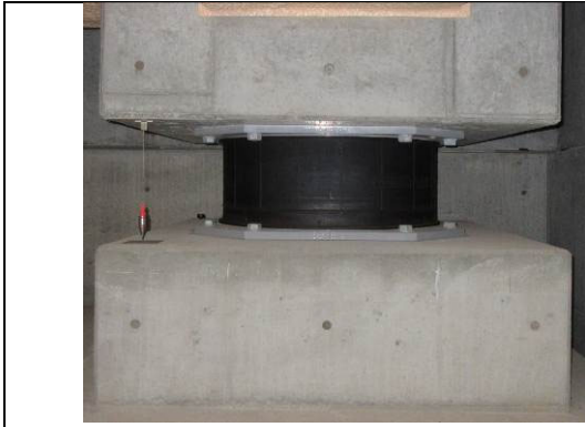
図 4.14-9 積層ゴムの様子
