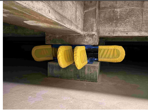
図 4.4-6 U型鋼材ダンパー
