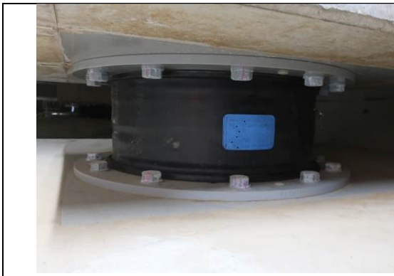
図 4.6-5 積層ゴムの様子
