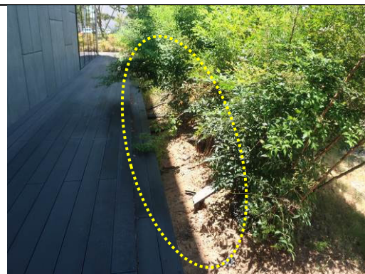
図 4.1-10 犬走りと植栽との接触（西面）
