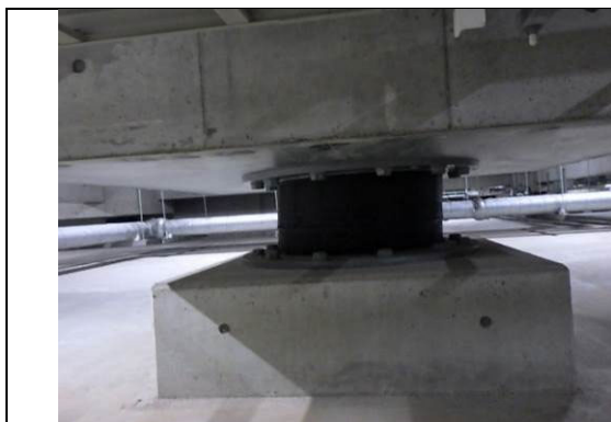
図 4.16-3 積層ゴムの様子
