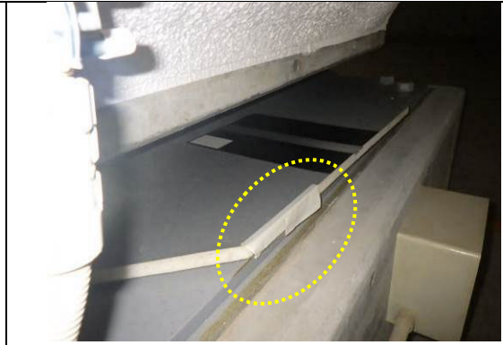
図 4.7-6 カバースプレートのずれ
