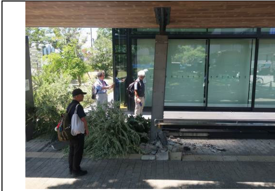
図 4.1-17 キャンopies柱の傾斜
