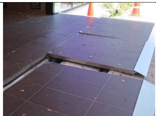
図 4.1-14 南側 Exp.J パネルのずれ
