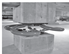
写真1 免震用 鋼棒ループダンパー
