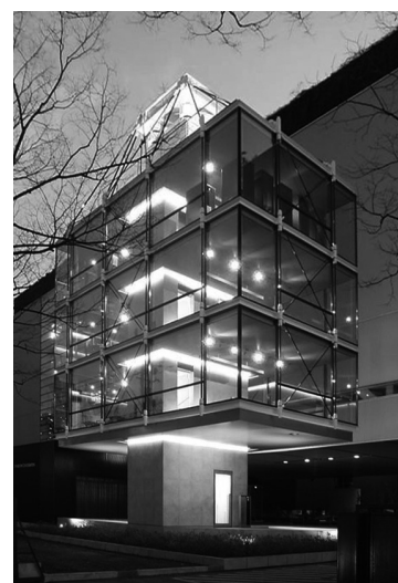
写真3 塔頂免震構造 (清水建設安全安震館,2006)
