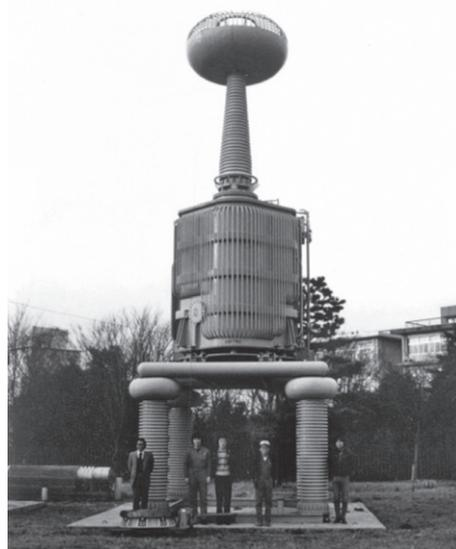
図1 100万V送電用変電装置の例と開発した10トン用重量機器用免震支持装置 (東京大学生産技術研究所千葉実験所にて撮影、1981年)
