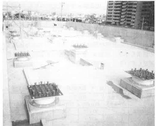
写真-2 免震部材設置状況(A1東棟)
