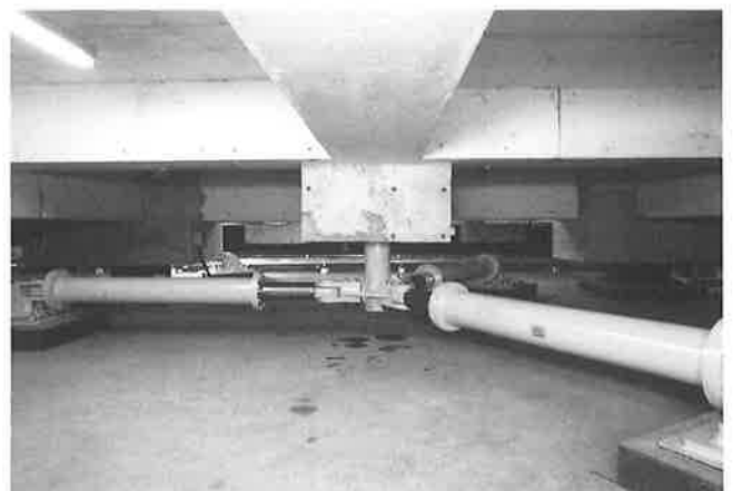
図-5 摩擦ダンパー(他建物での設置例)
