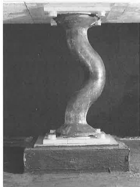
図-5 摩擦ダンパー(他建物での設置例)
