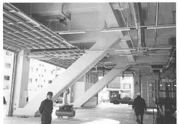
写真2 1階の斜め柱部分
