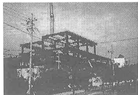
写真-2 鉄骨工事終了時全景
