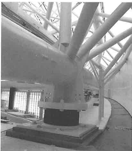
写真-4 積層ゴム支承とリングトラス
