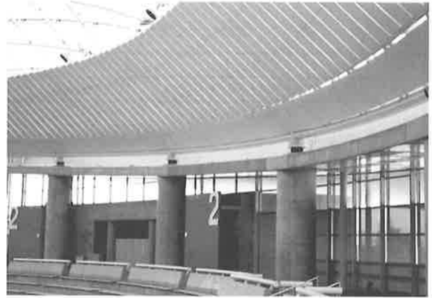
写真-5 独立柱と積層ゴム支承
