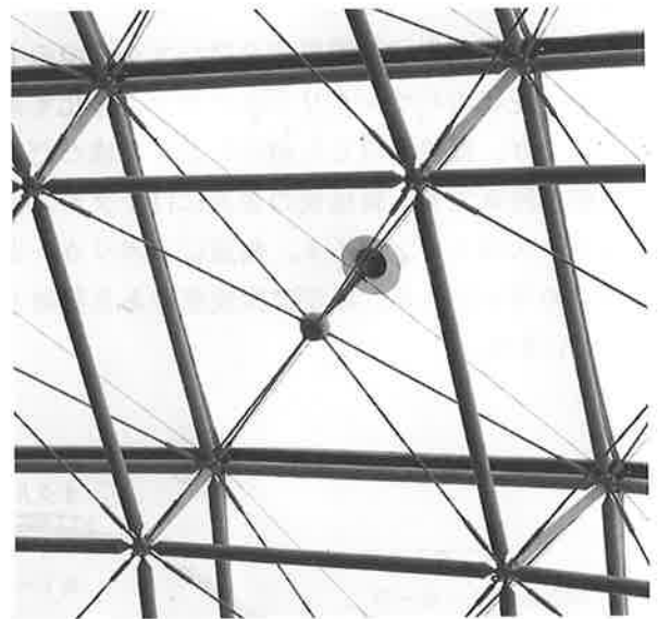
写真-3 テンセグリックトラス
