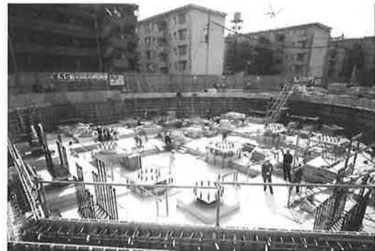
写真-1 建物工事全景
