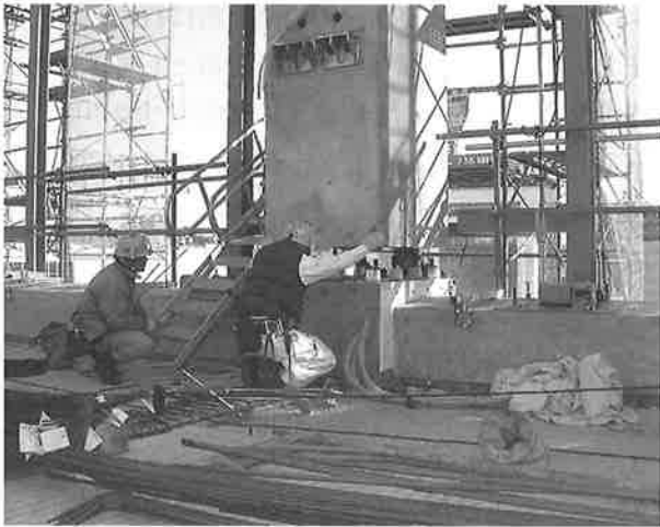
写真-3 柱設置状況
