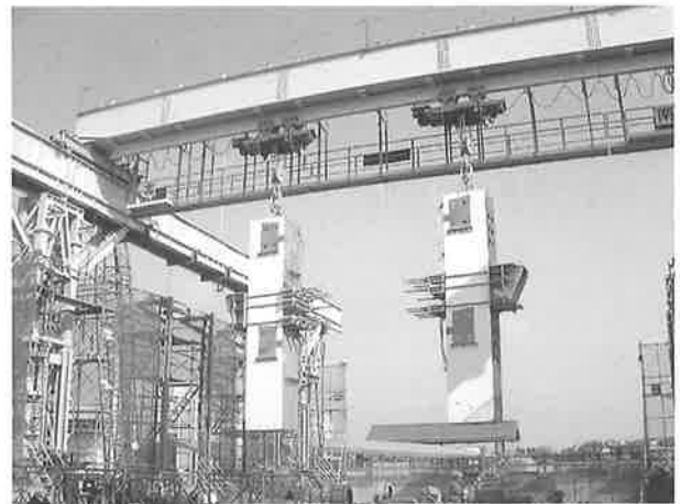
写真-2 天井クレーン用ブラケットを設置したPCa柱
