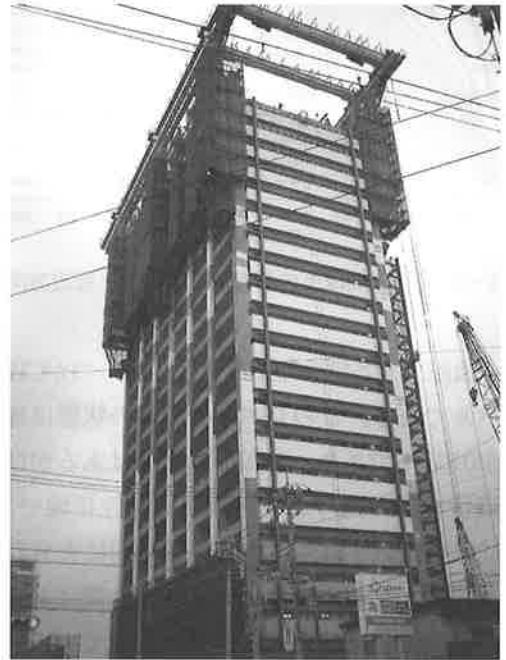
写真-5 天井クレーンシステムにて建設中の全景
