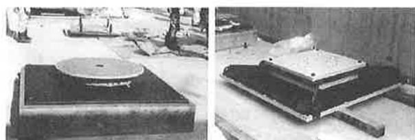
写真-1 “滑り支承” 取付け状況
