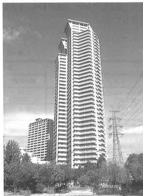
写真-1 建物全景 (2003年9月撮影・手前がT棟)
