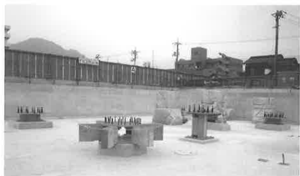
図-11 建物施工状況 (H15.9 現在)
