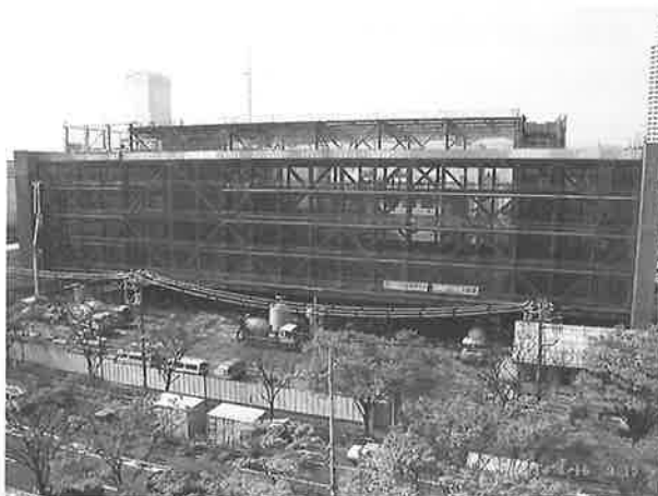
図-21 鉄骨建方終了時の状況
