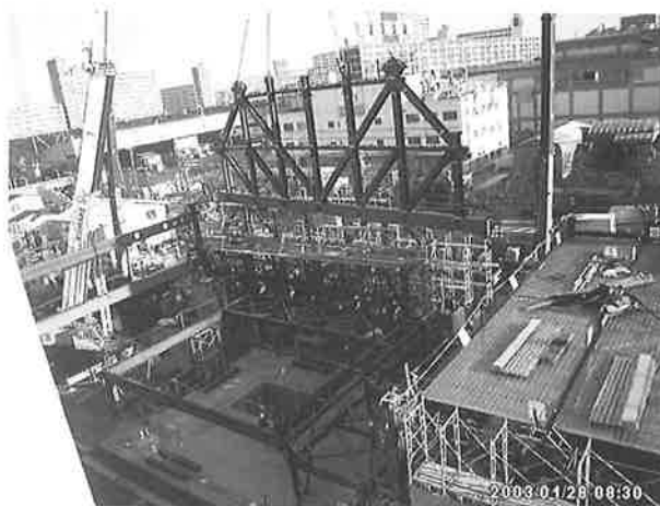
図-20 トラス建方状況
