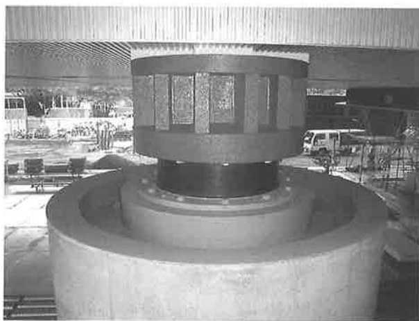
図-22 免震装置設置状況
