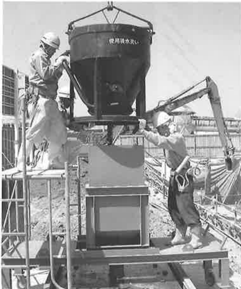
図-8 高流動コンクリート充填実験
