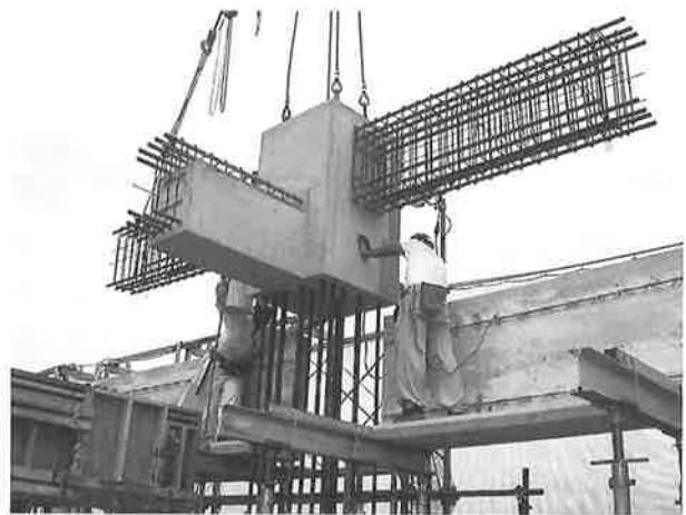
図-11 パネルゾーンPCa設置状況
